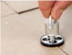
Per Hand oder mit dem Spezialschlüssel muss zeitnah die obere Grundplatte auf Klemmung gebracht werden, bis die Keramik eben und sauber ausgerichtet ist.
