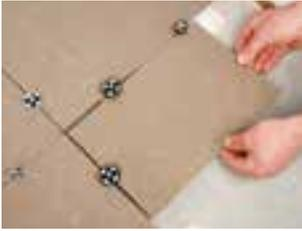
Die nächste dünnere Keramik in die Öffnung der beiden Fugenchips schieben und die gegenüberliegende Fliesenseite mit ebenfalls zwei Fugenchips versehen. Anschließend wieder in die frische Klebebettung drücken und ausrichten.
