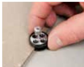
Die benetzte Keramikfläche mit Kleber versehen. Zwei Fugenchips (je nach Größe und Bedarf) anschließend auf die Fliesenkante setzen und in die mindestens 8 mm starke und frische Klebebettung eindrücken.
