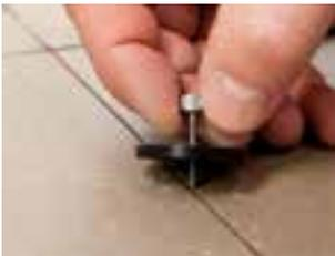
Nach Aushärtung des Fliesenklebers wird die obere Grundplatte mit dem Spezialschlüssel gelöst.
